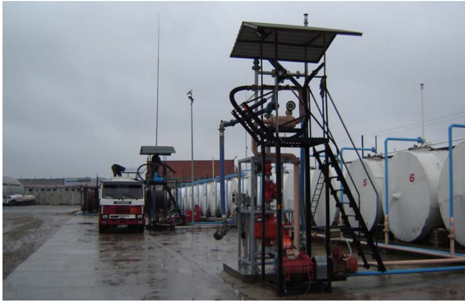
UAB Skulas terminalo benzino talpyklos-rezervuarai ir AC pildymo įrenginiai su garų grąžinimo linijomis
