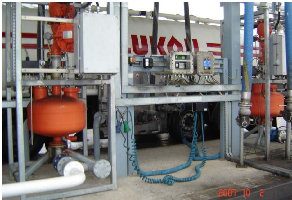
UAB Lukoil Baltija terminalo AC pildymo įrenginiai (apatinis pildymas)
