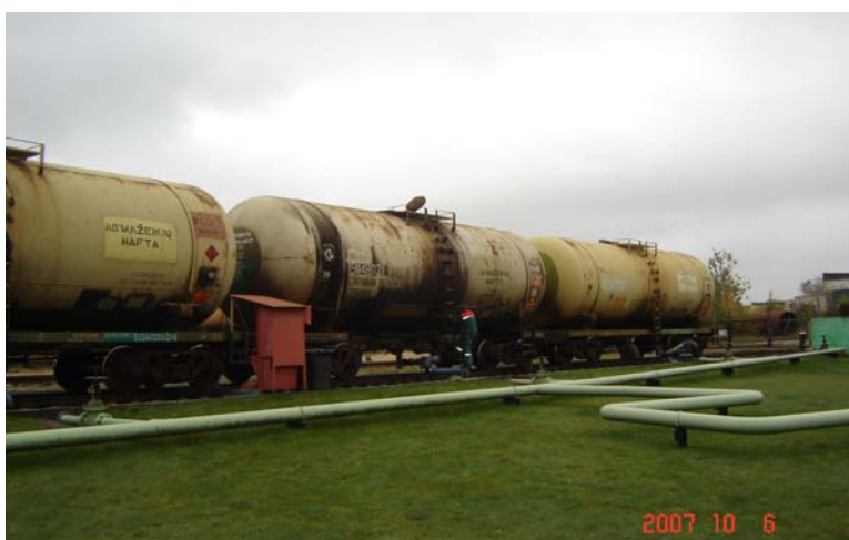
AVE-MATROX terminalo geležinkelio cisternų išpylimo estakada ir benzino cisternų vaizdas
