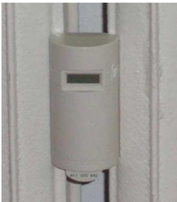
4 paveikslas. Elektroninis šilumos daliklis, pritvirtintas prie senos konstrukcijos radiatoriaus
