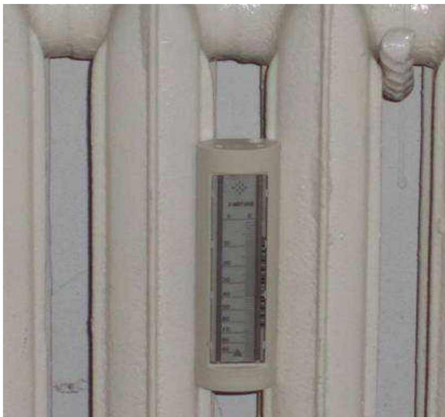
2 paveikslas. Ampulinis šilumos daliklis, pritvirtintas prie senos konstrukcijos radiatoriaus
