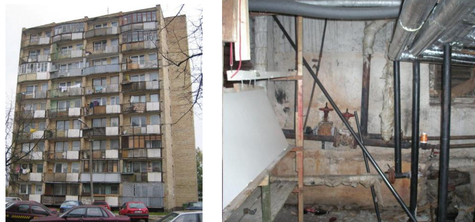
3 pav. Senas neprižiūrimas daugiabutis ir jo vidaus šildymo ir karšto vandens sistemos dalies būklė
